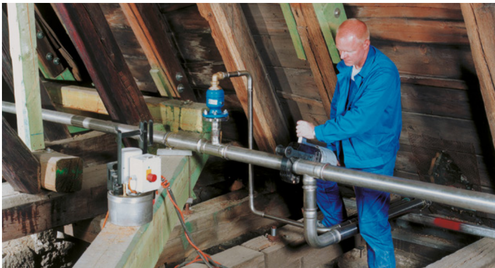
Essendo i raccordi totalmente meccanici, i collegamenti vengono effettuati a temperatura ambiente e si evitano rischi di incendio. Foto: Geberit, Jona (CH)
